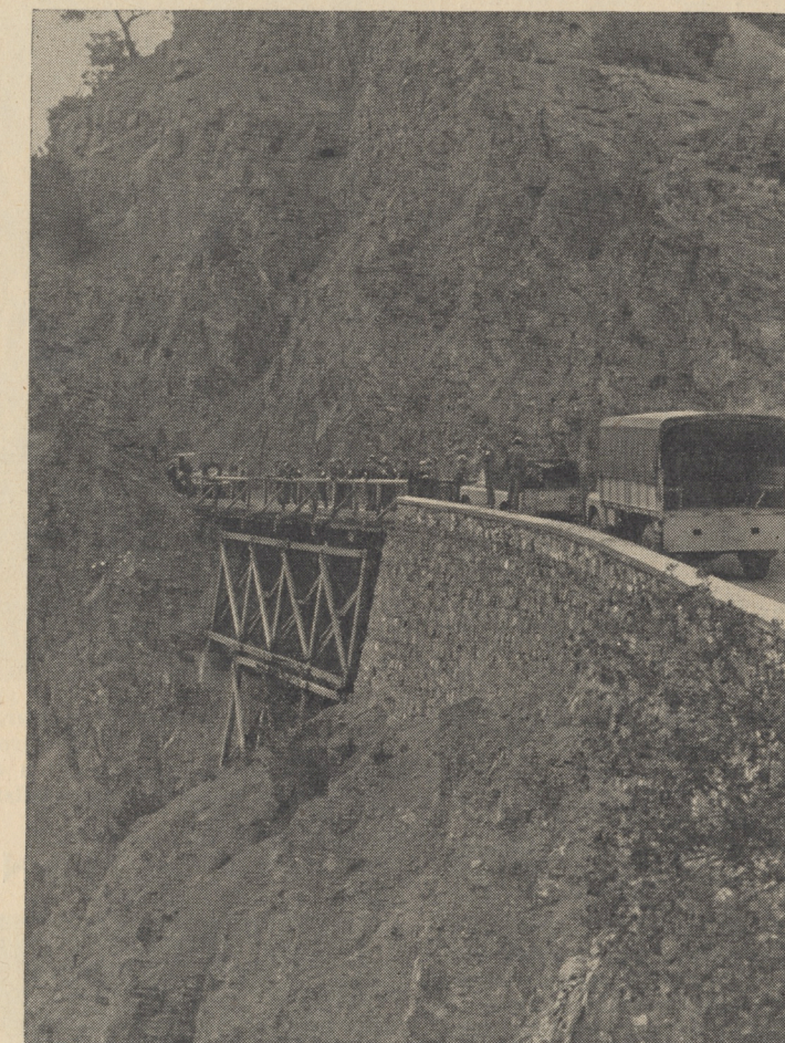
Tauko matkalla Kykkos-luostariin. Kyproslaista insinööritaitoa tutkitaan. Millä tavalla on tie pistetty menemään hankalan paikan läpi miten tukeva on silta?
